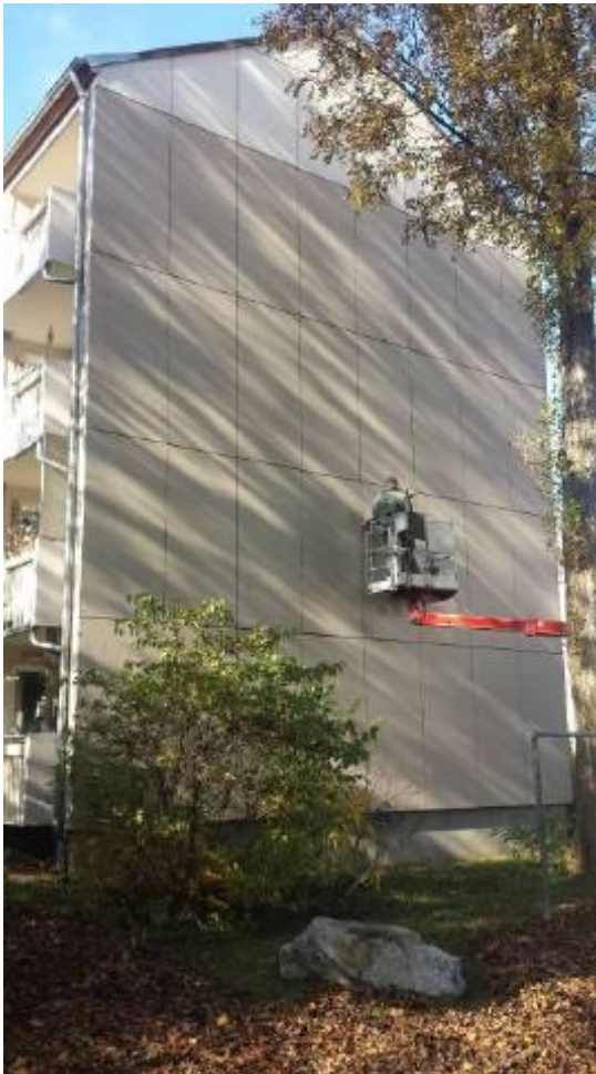
Demontage einer Fassadentafel
