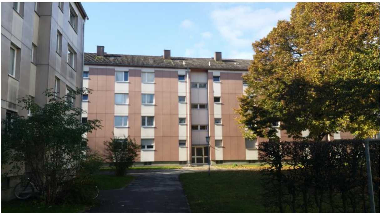
Wohnhausanlage München, errichtet Anfang der 1980er Jahre
