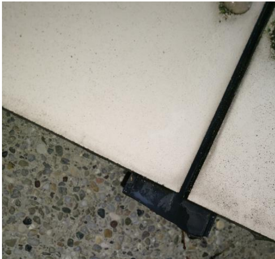
EPDM Band 1,3 mm zum Schutz der Traglatten vor Feuchtigkeit
